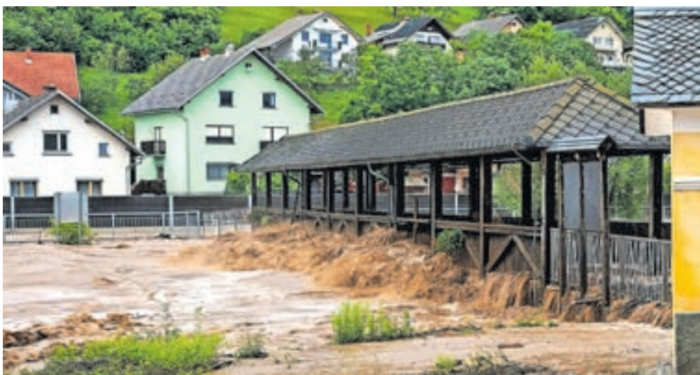
V Gorenji vasi je bilo poškodovanih kar nekaj mostov, ta je na srečo vzdržal. / Foto: Jure Ferlan
