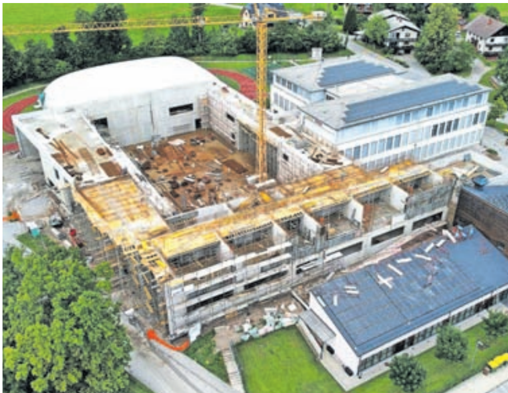
Gradnja športne dvorane s širitvijo osnovne šole v Preddvoru sicer lepo napreduje, je pa izvajalcem del na objektu nedavno ponagajalo nepredvidljivo vreme z vetrom in močnimi padavinami. / Foto: arhiv občine (Dušan Zaplotnik)
