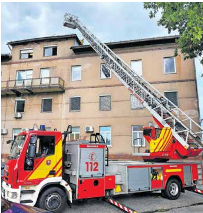
Na eni do stavb jeseniške bolnišnice je odkrilo del strehe.
