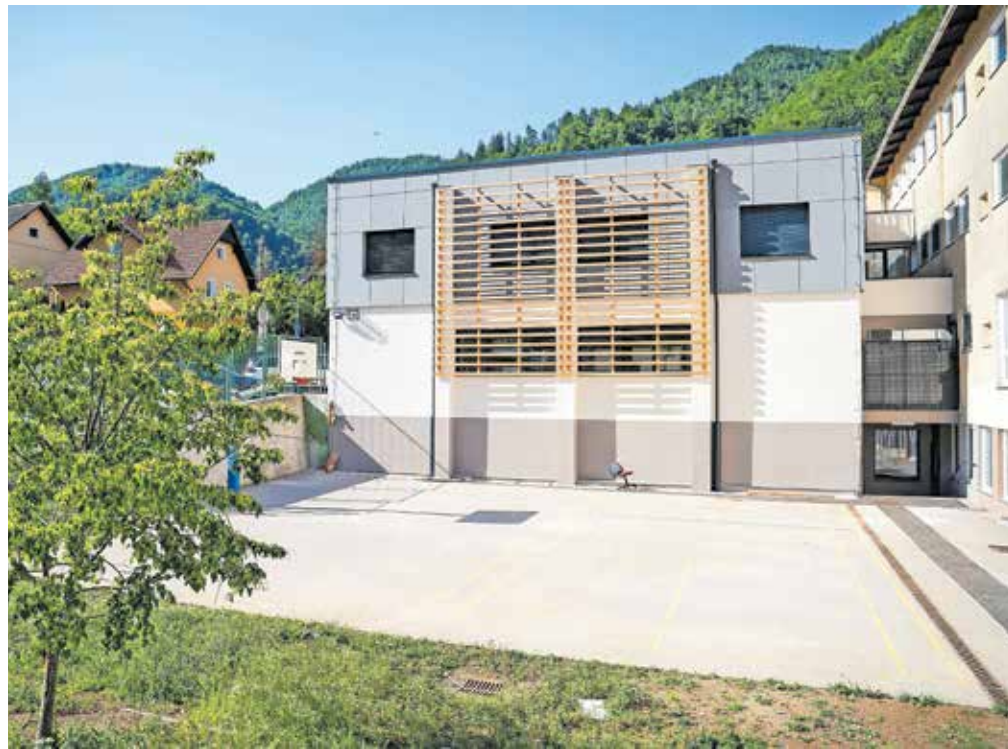
Obnovljeni prizidek Osnovne šole Poldeta Stražišarja Jesenice: v pritličju je povsem prenovljena telovadnica, nad njo pa so zgradili še eno etažo, kjer so novi prostori uprave šole. / Foto: Nik Bertonec
