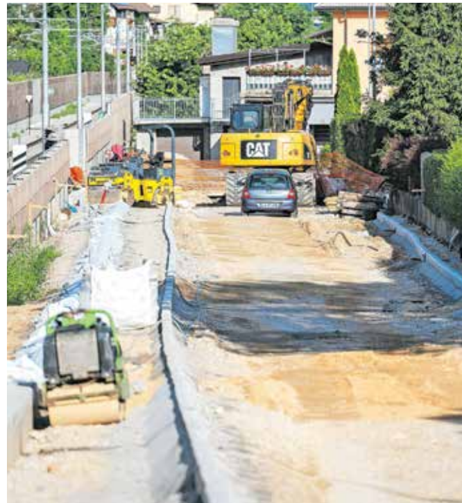
Ob stavbi TVD Partizan so začeli polagati granitne robnike ob cesti in granitne kocke kot zaključek pločnika. / Foto: Nik Bertonec
