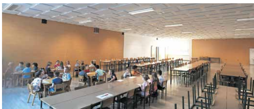
V jedilnici OŠ Železniki je bil hrup šestkrat prekoračen, zato so izvedli akustično oblogo sten in stropa. / Foto: Gorazd Kavčič
