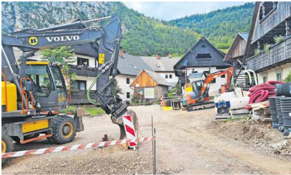
Središče vasi je v teh dneh veliko gradbišče.
