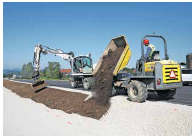
Gradnja ceste Hotemaže-Britof bi bila lahko sklenjena približno pol leta pred rokom. / Foto: Gorazd Kavčič
