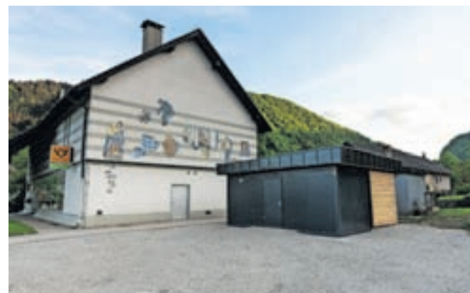
V prvi fazi so na tržnem prostoru na Češnjici postavili kontejner s sanitarijami, skladišče in prostor za odpadke.
