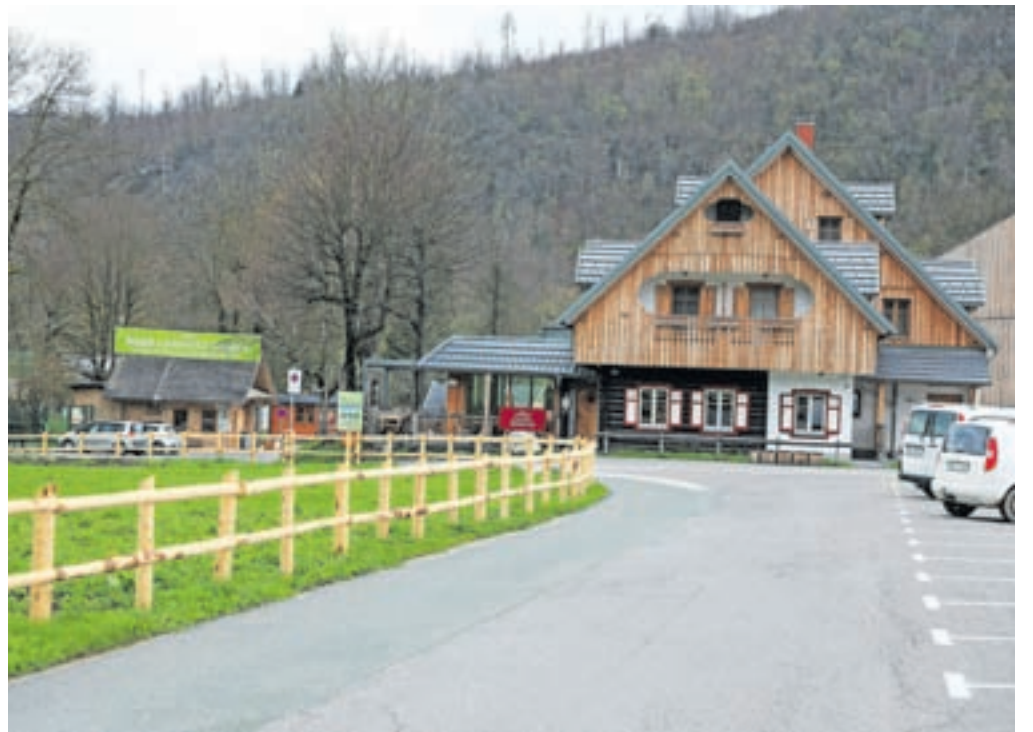
Prvi naslednji projekt je gradnja novega sanitarnega bloka, za njim pa ureditev šestih glamping hišk. Temu bo sledila ureditev bazenskega kompleksa. / Foto: Tina Dokl
