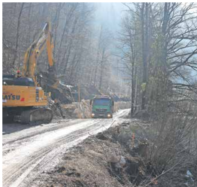
Gradbena dela za kolesarsko povezavo med Bledom in Bohinjem za zdaj tečejo v skladu z načrti. / Foto: Gorazd Kavčič
