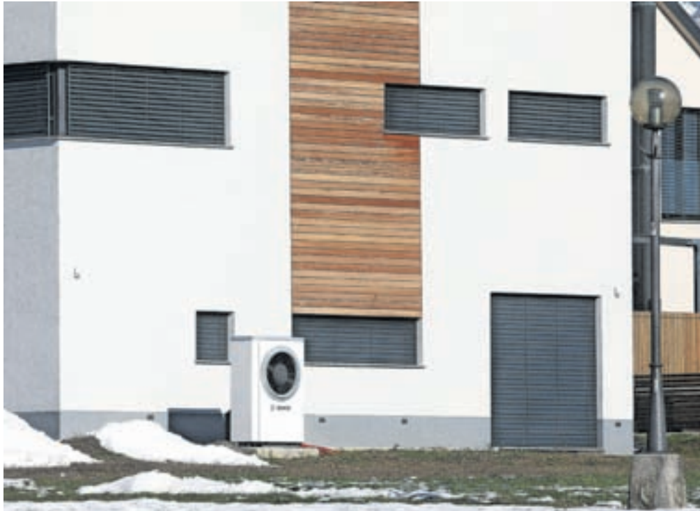
Za energetska sanacijo in zamenjavo ogrevalnega sistema je na voljo več spodbud. Fotografija je simbolična. / Foto: Gorazd Kavčič
