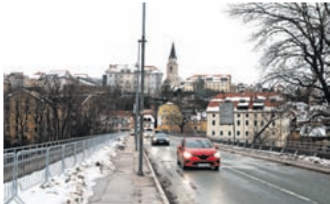
Promet po mostu čez Savo na Ljubljanski cesti v Kranju od danes ni več mogoč. / Foto: Gorazd Kavčič
