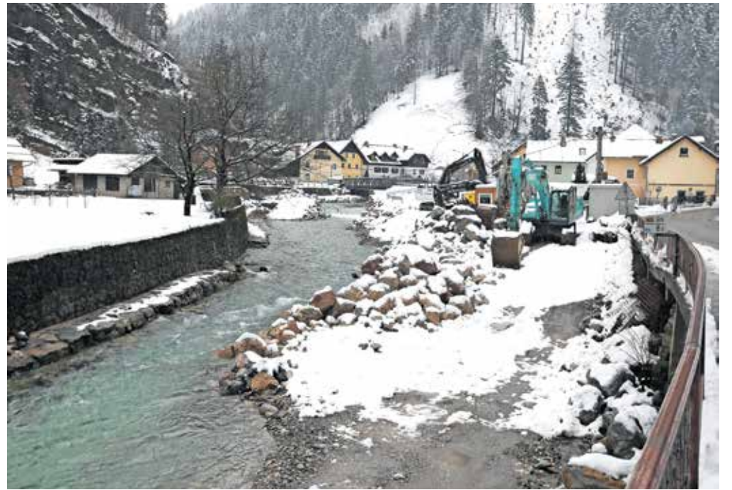
V Železnikih že od predlanske jeseni poteka obsežen projekt protipoplavne ureditve porečja Selške Sore. / Foto: Gorazd Kavčič
