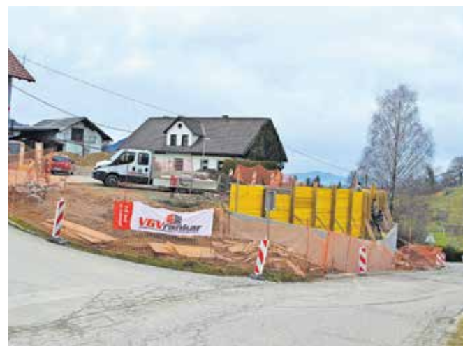
Dela na Selih že potekajo. / Foto: Damijan Rifi
