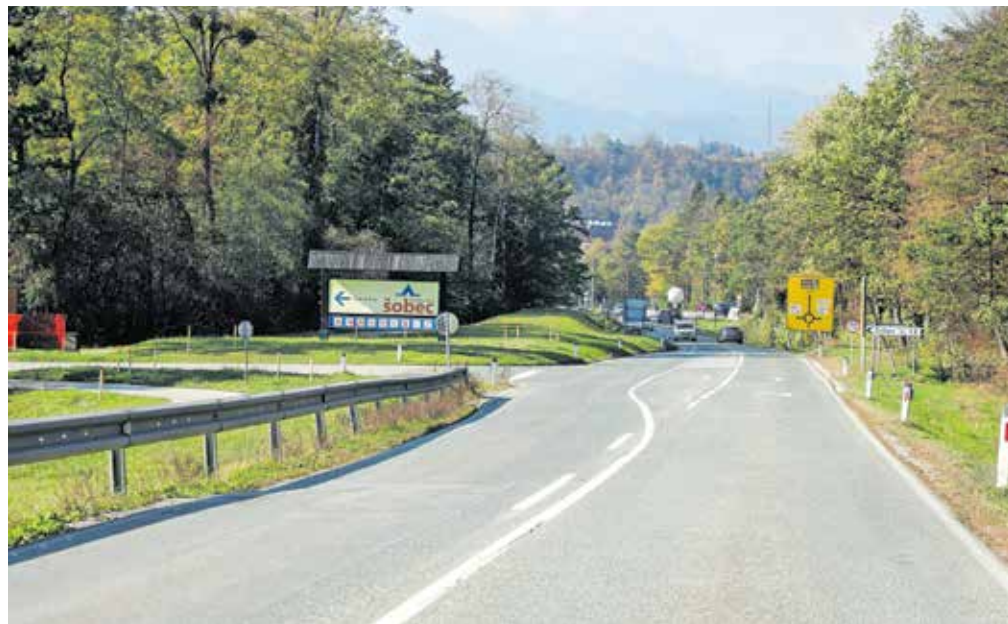
Začela se je gradnja krožišča na državni cesti Lesce–Bled z odcepom za Šobec. / Foto: Tina Dokl
