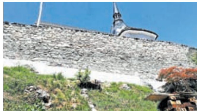
Zahtevna sanacija opornega zidu pri cerkvi sv. Lenarta v Kropi je zaključena.
