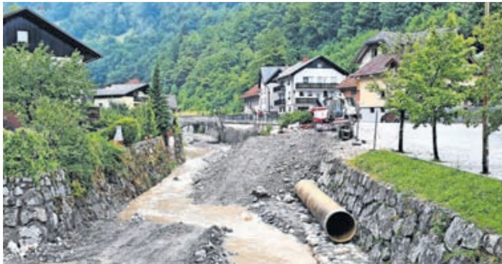
Gradnja protipoplavnih ukrepov na Selški Sori v Železnikih / Foto: Ana Šubic
