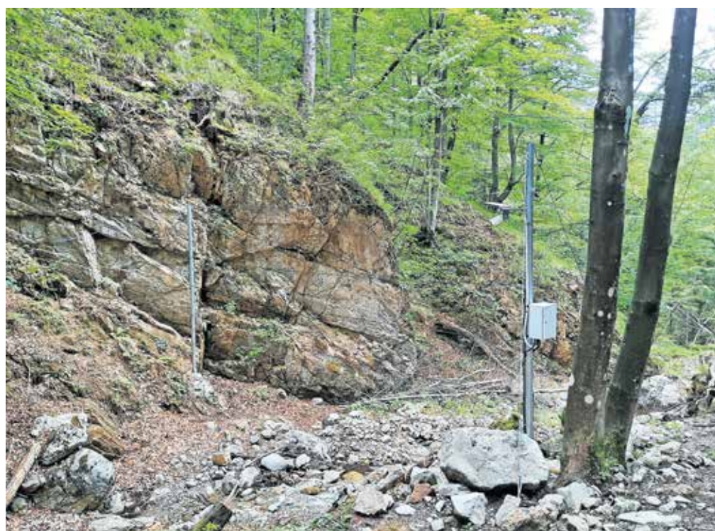
Potezne zanke so povezane s sirenami, ki se bodo sprožile v primeru, ko bi večja količina materiala prekinila zanko. / Foto: arhiv Občine Jesenice
