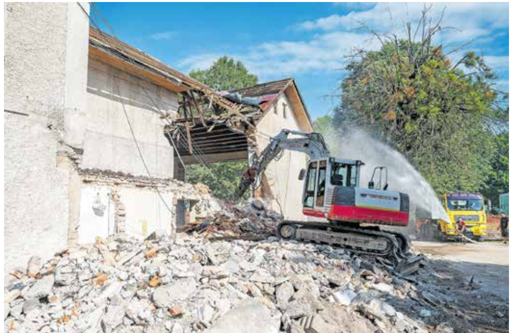
Stavbo nekdanjega Telovadnega društva Partizan v Radovljici so konec tedna začeli rušiti. Kot so poudarili investitorji, so spominsko ploščo, ki je bila nameščena na pročelju, skrbno odstranili in poskrbeli za restavracijo, nato pa jo bodo umestili v kompleks novega objekta. / Foto: Nik Bertonec
