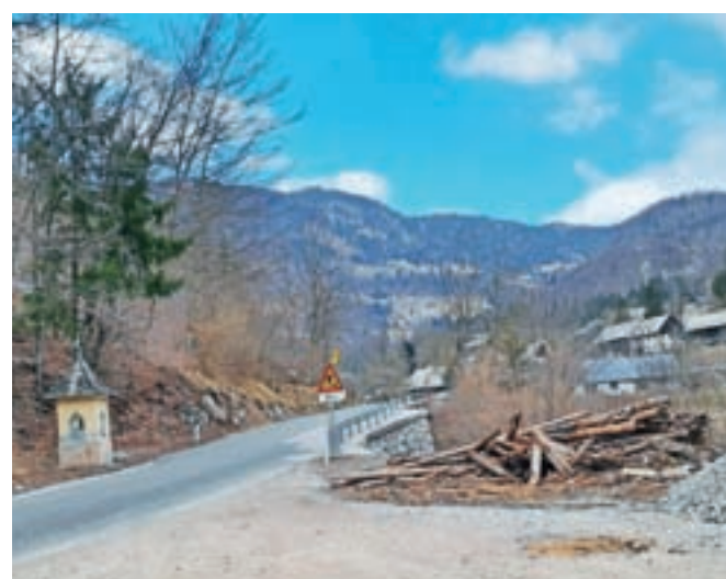
Povezovalni vod Studor–Bohinjska Bistrica, ki bo naselja Bohinjska Češnjica, Studor, Srednja vas in Jereka povezal s centralno čistilno napravo v Bohinjski Bistrici, je že v gradnji.
