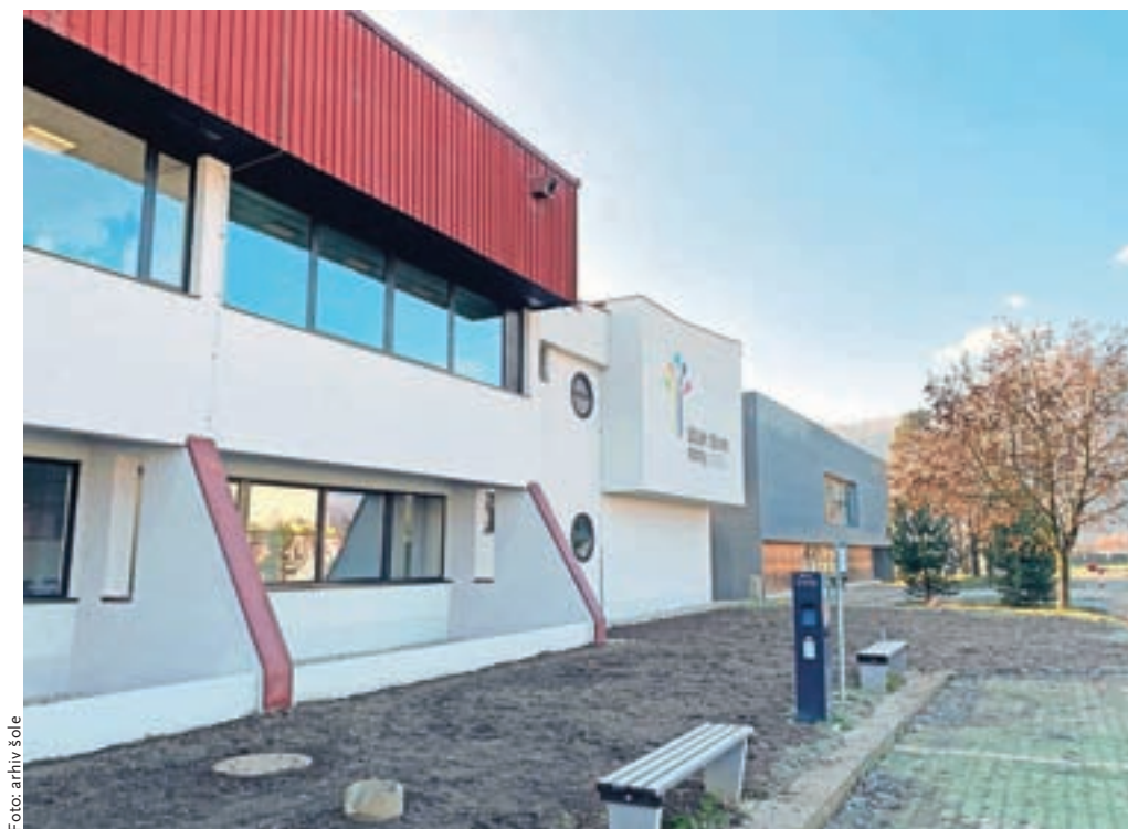
Lani so že poskrbeli tudi za celovito energetska sanacijo šolske stavbe na Kidričevi cesti.
