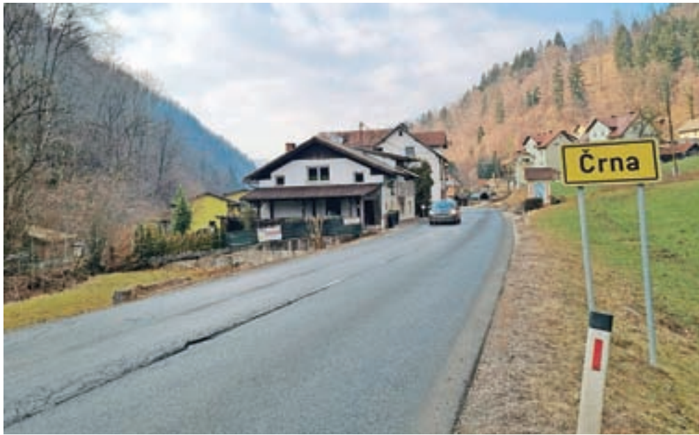
V Črni bodo dobili nov asfalt pa tudi kanalizacijo.
