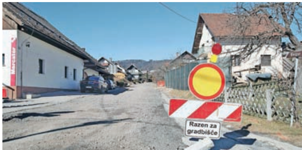
V času gradnje bo zaradi zapor obvoz potekal po lokalnih cestah. / Foto: Gorazd Kavčič
