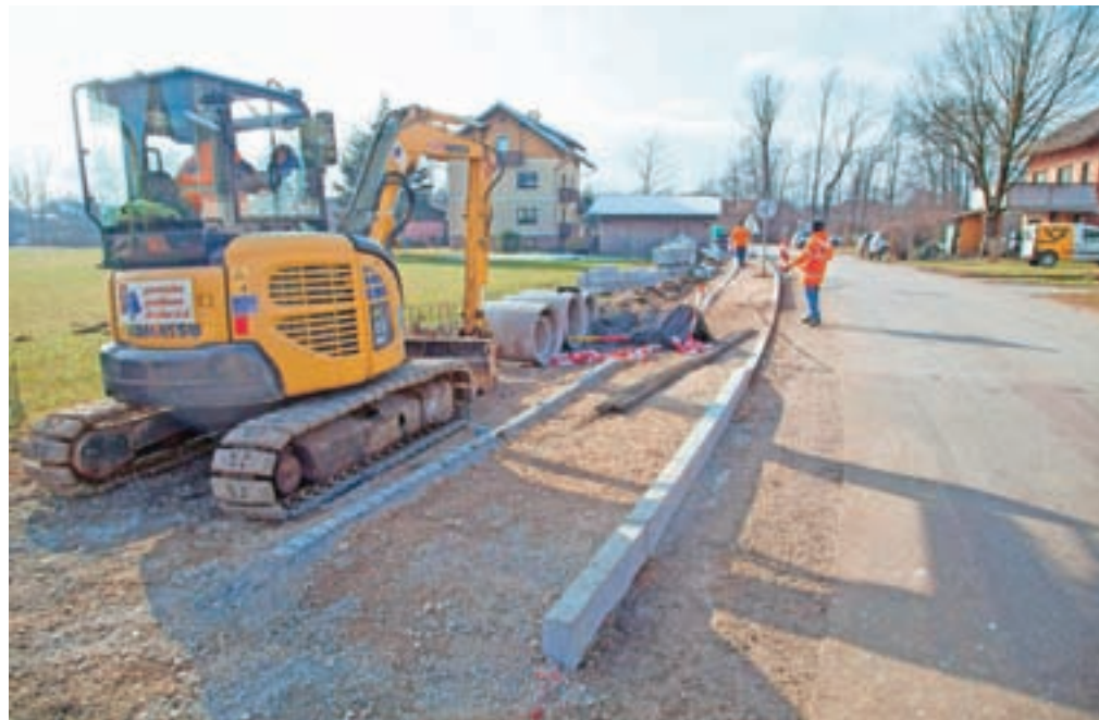
V Zalogu poteka gradnja pločnika.
