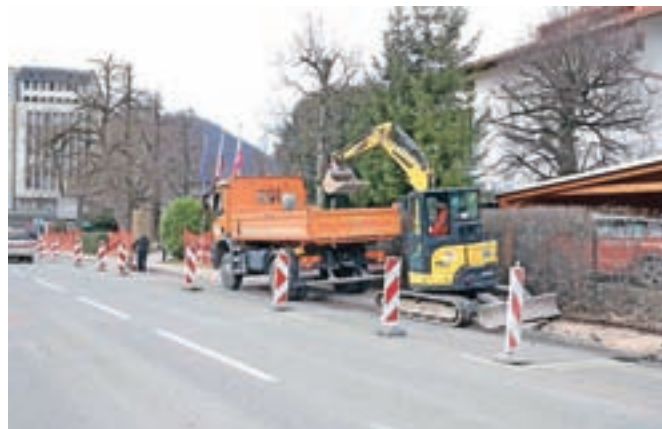
Gradnja na delu Ceste Staneta Žagarja / Foto: Tina Dokl
