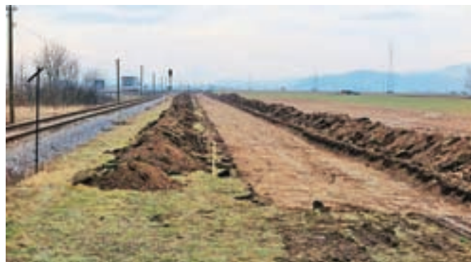
Gradnja kolesarske povezave na Dupliškem polju
