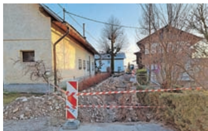
Gradbena dela na Zduši
