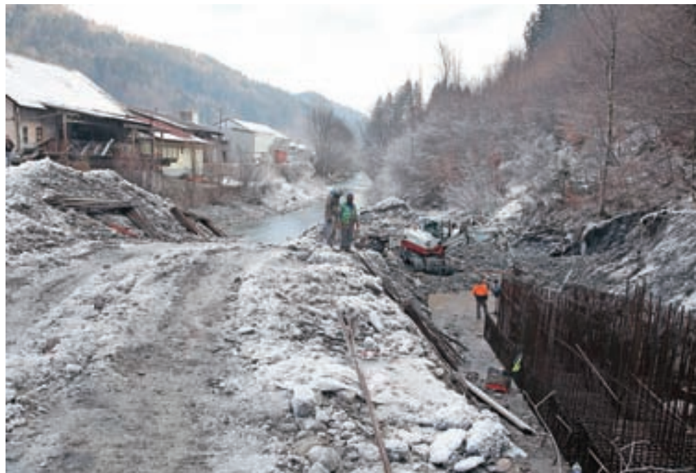
Gradnja protipoplavnih ukrepov v Železnikih / Foto: Gorazd Kavčič
