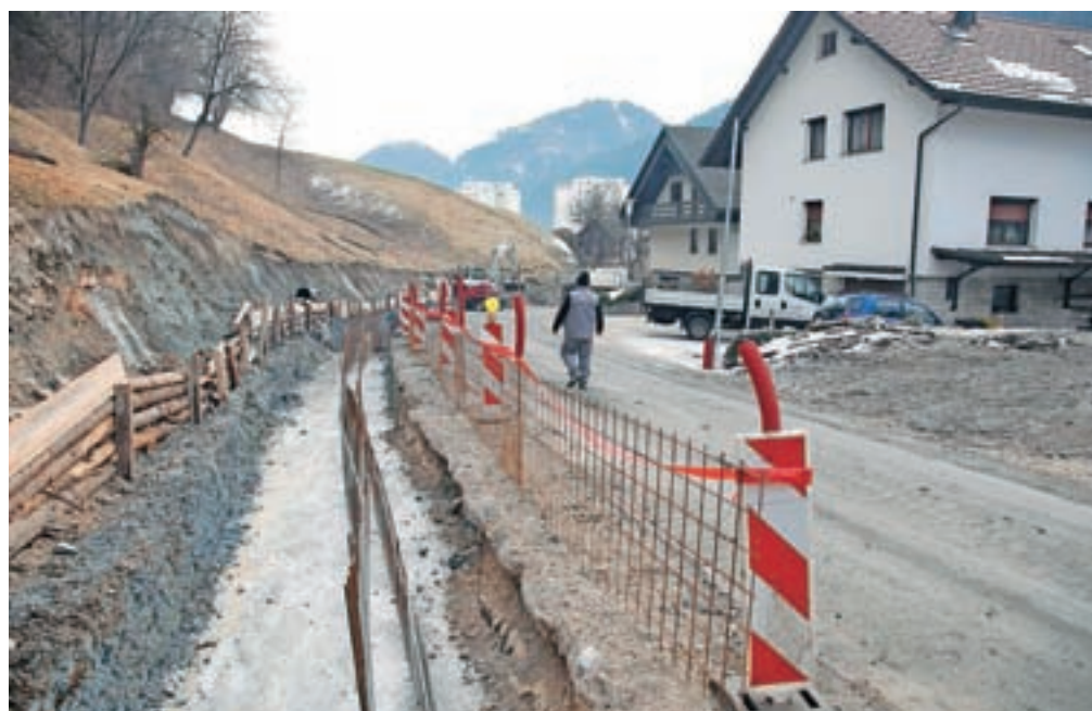
Ta čas poteka gradnja opornih zidov ob cesti. / Foto: Gorazd Kavčič
