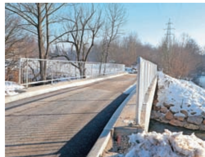
Novi most čez Rupovščico je dokončan. / Foto: MOK
