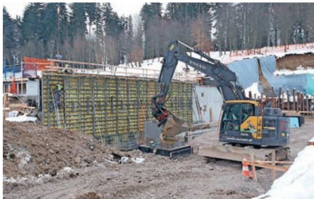
Radovljiški bazen je v teh dneh veliko gradbišče. Več kot štiri milijone evrov vredna investicija v prvo fazo obnove naj bi bila končana v letu in pol. /Foto: Gorazd Kavčič
