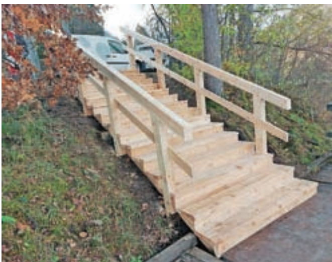
Stopnišče in ograja v Veliki Zaki sta v celoti obnovljena
