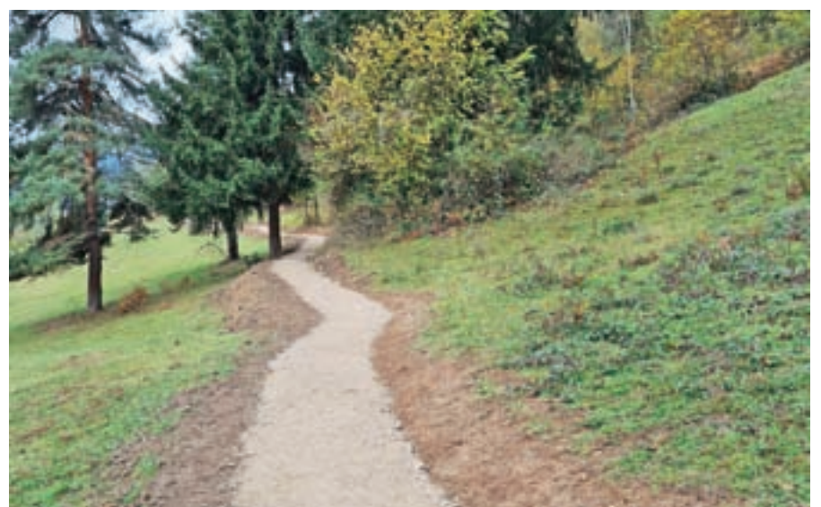
Delavci Infrastrukture Bled so v novembru uredili dobro tretjino sedemsto metrov dolgega odseka te poti. V naslednjem letu bo Občina Bled urejanje in sanacijo nadaljevala.
