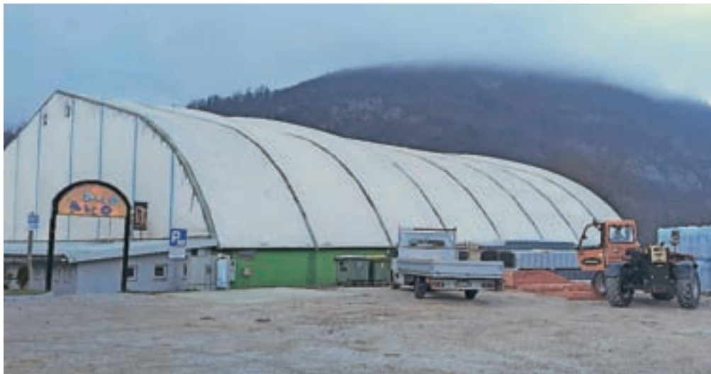
Streha objekta, ki je bil v osnovi zasnovan kot šotor, je že tako dotrajana in poškodovana, da bi bilo ob večjem deževju zadrževanje pod njo lahko nevarno.
