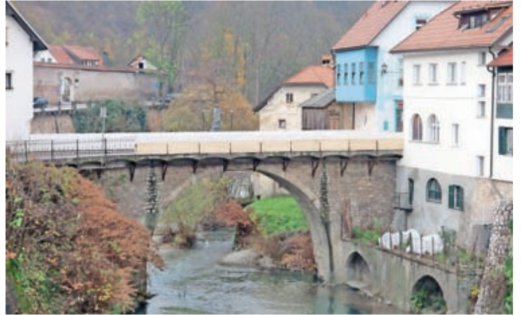
Pred kratkim se je začela obnova Kamnitega mostu. / Foto: Vilma Stanovnik
