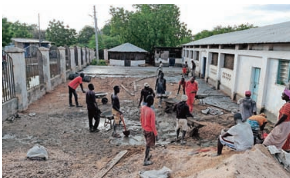
Pripravljanje betona in betoniranje / Foto: osebni arhiv
