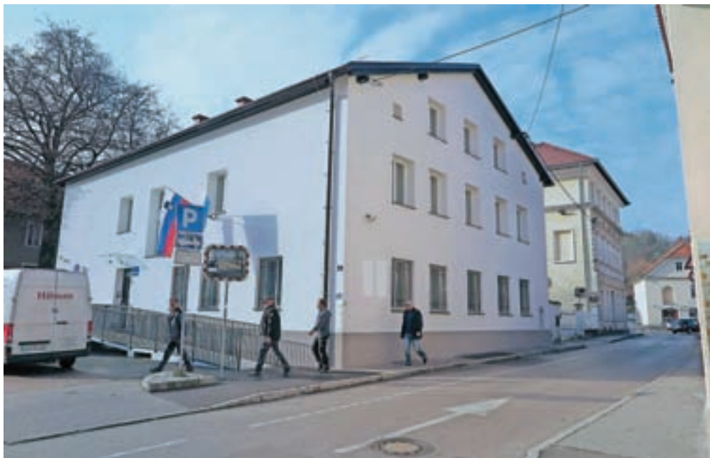
Policijska postaja Kamnik ima novo in energetsko varčno fasado.
