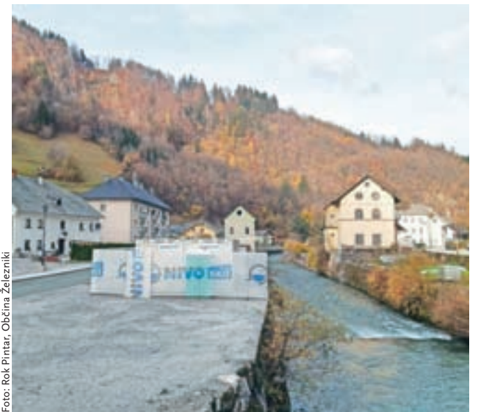
Na terenu poteka izvajanje predhodnega monitoringa, prav tako so že postavili nekatere gradbišne kontejnerje.
