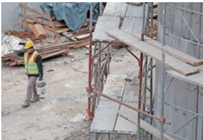
Skoraj šestnajst odstotkov hitro rastočih podjetij iz panoge gradbeništva. / Foto: Gorazd Kavčič
