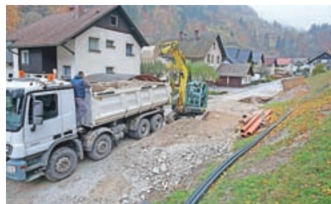
Gradnja komunalne infrastrukture v Dašnici / Foto: Gorazd Kavčič
