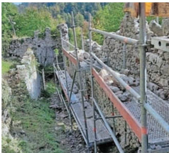
Obnova zidov obrambnega hodnika na Starem gradu
