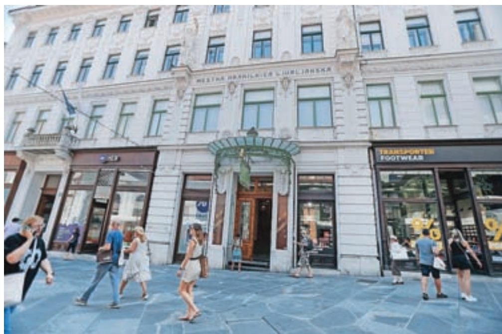
Stavba nekdanje Mestne hranilnice ljubljanske, danes pa je v njej Muzej bančništva Slovenije Bankarium / Foto: Tina Dokl
