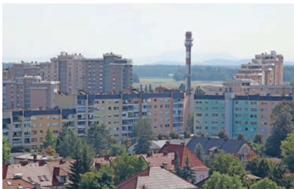
Upravljalci sistemov daljinskega ogrevanja in skupnih kotlovnici cene ogrevanja že prilagajajo spremembam cene elektrike, zemeljskega plina in drugih energentov na mednarodnem trgu. / Foto: Gorazd Kavčič
