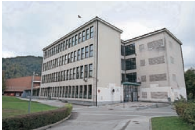
Stara šolska zgradba bodo po izgradnji nove v neposredni bližini porušili. / Foto: Gorazd Kavčič
