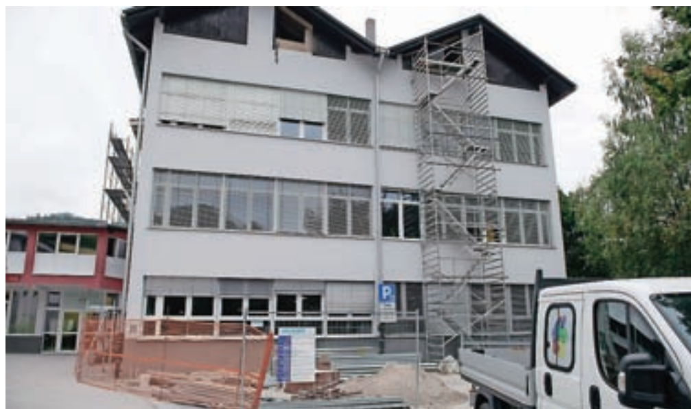
V mansardi OŠ Železniki bodo uredili tri učilnice in ob stavbi zgradili dvigalo. / Foto: Primož Pičulin
