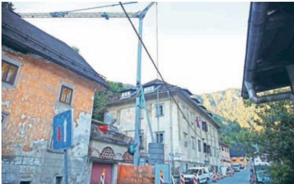
Ta teden so začeli obnavljati streho in ostrežje Klinarjeve hiše v Kropi. Obnovitvena dela bodo predvidoma končana do konca novembra. / Foto: Gorazd Kavčič
