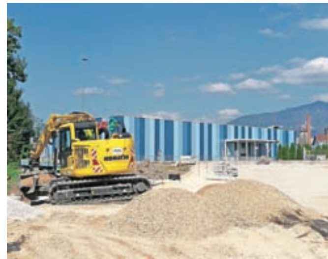
Občina Kamnik te dni gradi nov priključek Radomeljske ceste na obvoznico, kar je eden od pogojev za protipoplavno sanacijo struge in ureditev manjkajočega odseka rekreativne poti ob Kamniški Bistrici.
