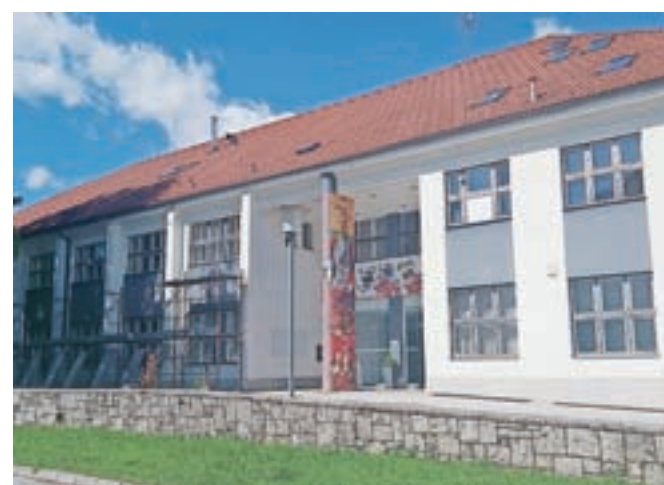
Konec avgusta se je začela energetska sanacija Doma kulture Kamnik.
