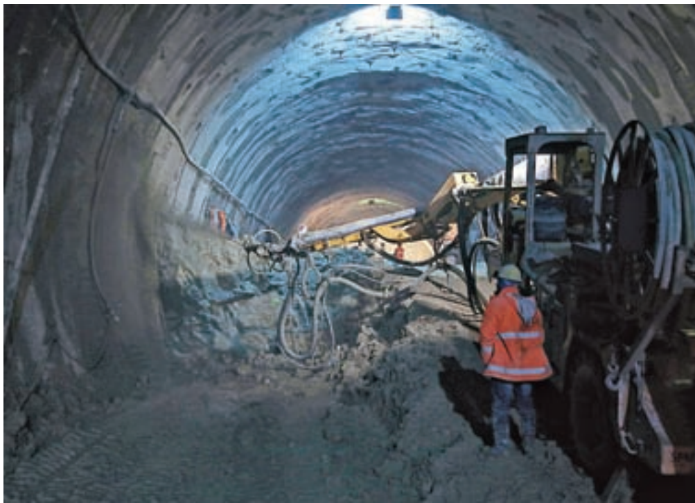
Do začetka tedna je Cengiz izvrtal 1285 metrov druge cevi, dela pa potekajo v skladu z načrti. V zadnjem obdobju vsak teden napredujejo za petdeset metrov. / Foto: Gorazd Kavčič
