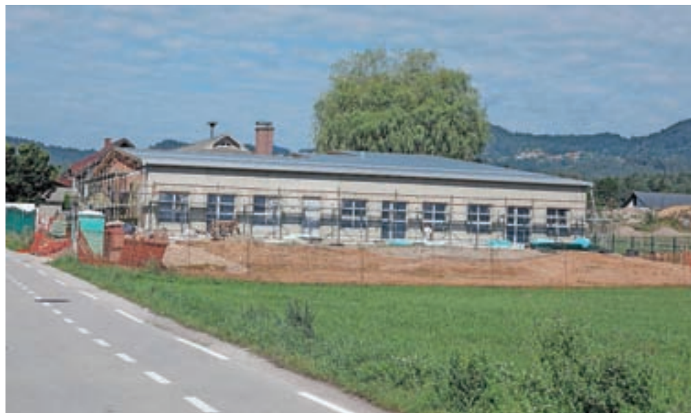
Na novem vrtcu Biba trenutno izdelujejo fasado, v notranjosti pa estrihe. / Foto: Tina Dokl
