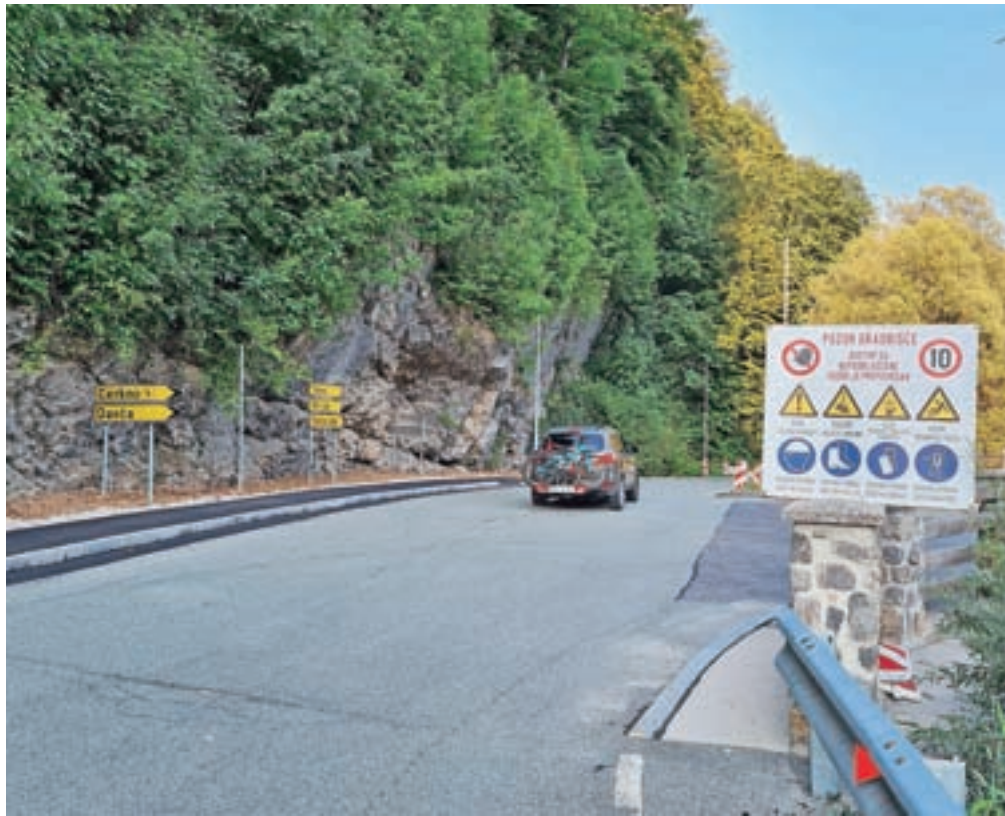
Urejanje avtobusnega postajališča na državni cesti pri davškem mostu
