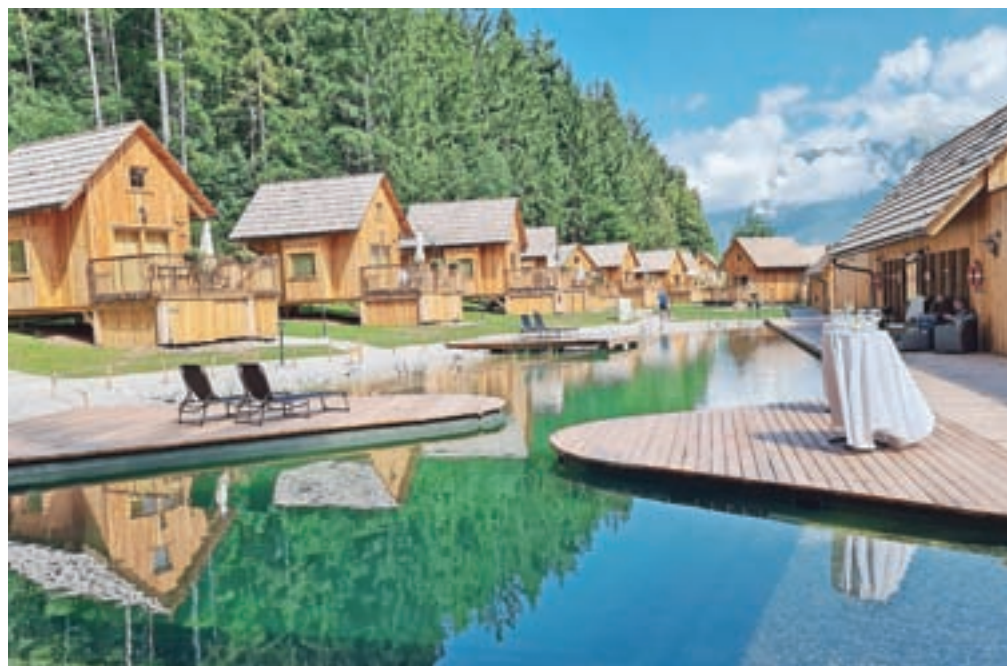
Kolesarska vas v Ribnem, naselje 17 luksuznih hišic, narejenih z mislijo na ljubitelje kolesarjenja
