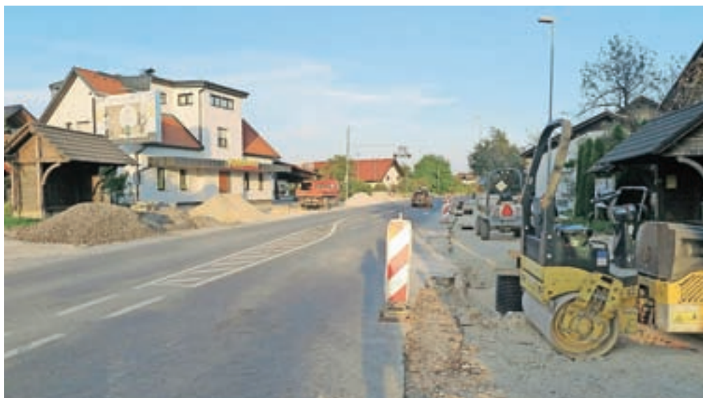
Skozi Godešič se v dolžini dobrega kilometra izvajajo ukrepi za umirjanje prometa, urejajo se površine za pešce in kolesarje, vsi lokalni in hišni priključki, avtobusna postajališča, poteka obnova obstoječe voziščne konstrukcije. Urejeni bodo tudi odvodnjavanje, cestna razsvetljava in prometna oprema ter signalizacija.
