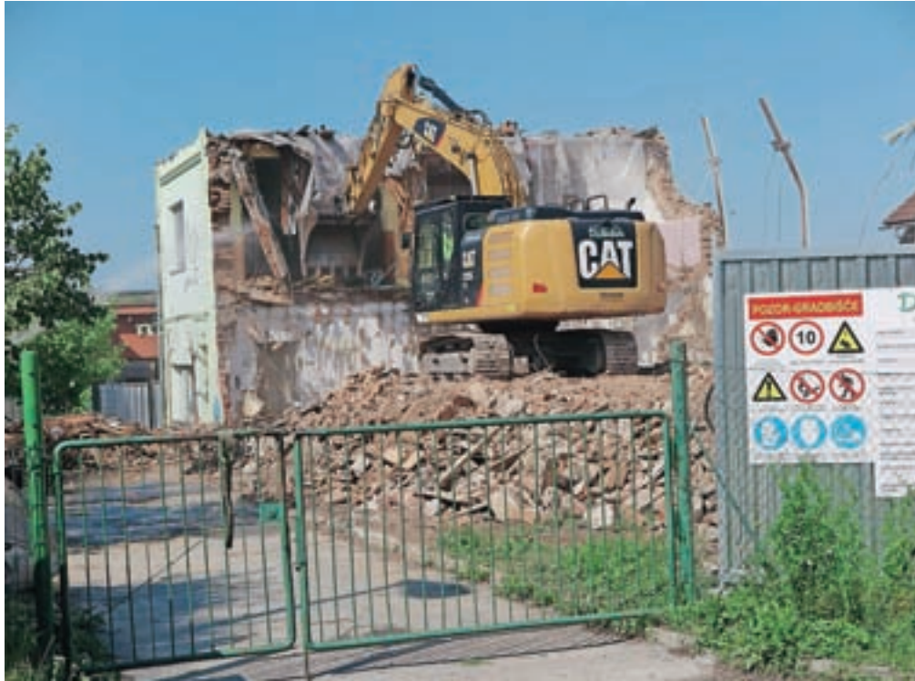
Stavba starega vrtca v Valburgi je bila zgrajena leta 1912. Prvotno je bila v njej gostilna s kegljiščem. Enota vrtca se je tam odprla v marcu 1979. V tem tednu se je začela rušitev objekta, ki naj bi bila končana prihodnji teden.
