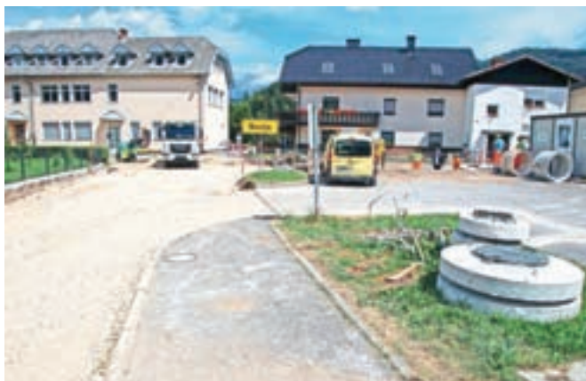
Gradnja površin za kratkotrajno parkiranje pri Podružnični šoli Nevlje
