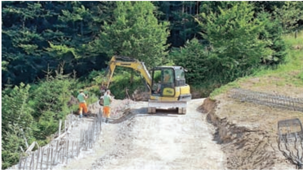
Sanacija plazu Špitalič-Dolina sodi med zelo zahtevne. / Foto: Občina Kamnik
