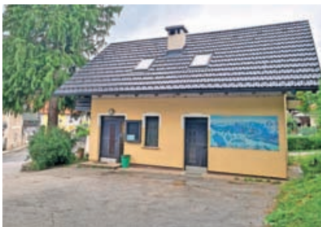
Nekdanja stavba turističnega društva v Preddvoru je najprej dobila novo streho.
