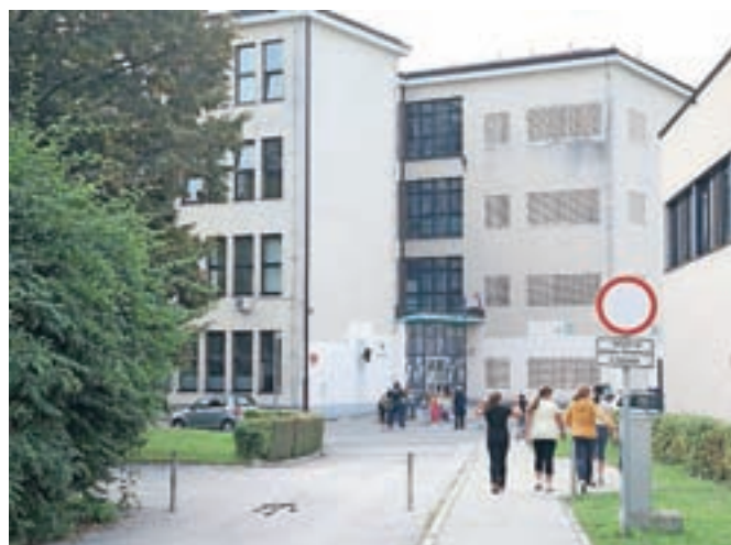
Ob obstoječi OŠ Frana Albrehta bo predvidoma v začetku jeseni začela rasti nova stavba; staro bodo porušili. / Foto: Gorazd Kavčič
