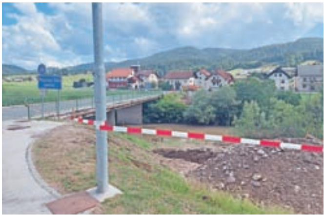
V Gorenji vasi so se začela pripravljala dela za gradnjo novega mostu čez Soro. / Foto: arhiv občine
