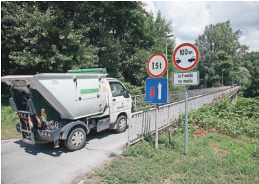
Most pri Planiki bodo lahko porušili in nadomestili z večjim še pred začetkom gradnje sosleske Ob Savi. / Foto: Gorazd Kavčič
