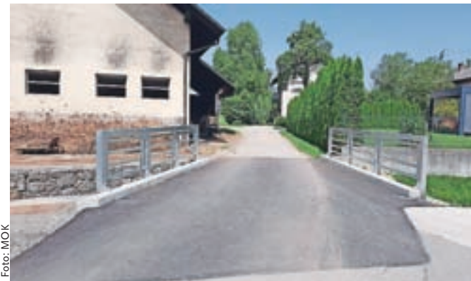
Saniran prepust potoka Belca na Suhi pri Predosljah
