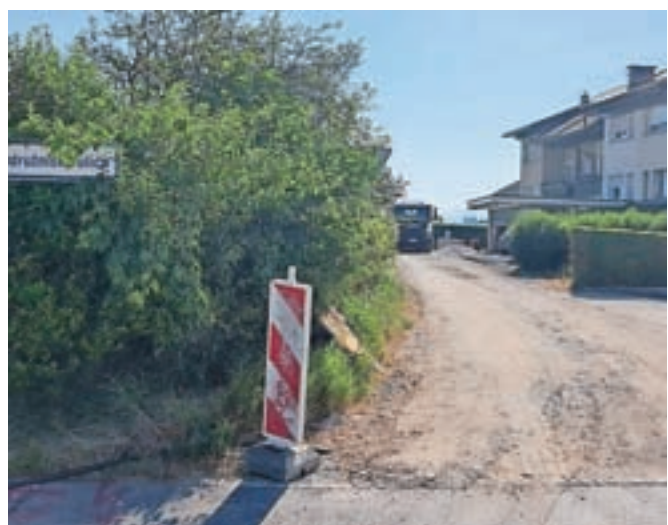
Obnova vodovoda v Mengšu / Foto: Občina Mengeš
