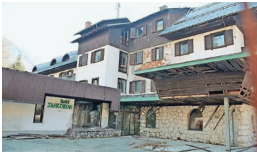
Stari propadajoči Hotel Zlatorog v Ukancu bodo porušili in na njegovem mestu zgradili nov, sodoben hotelski kompleks. / Foto: Gorazd Kavčič
