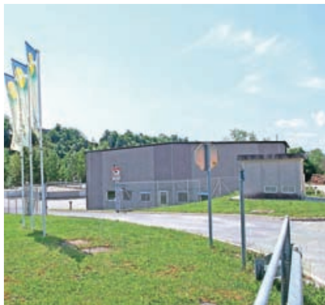
Kanalizacijski sistem se v občini Tržič zaključuje s Centralno čistilno napravo. / Foto: Primož Pičulin
