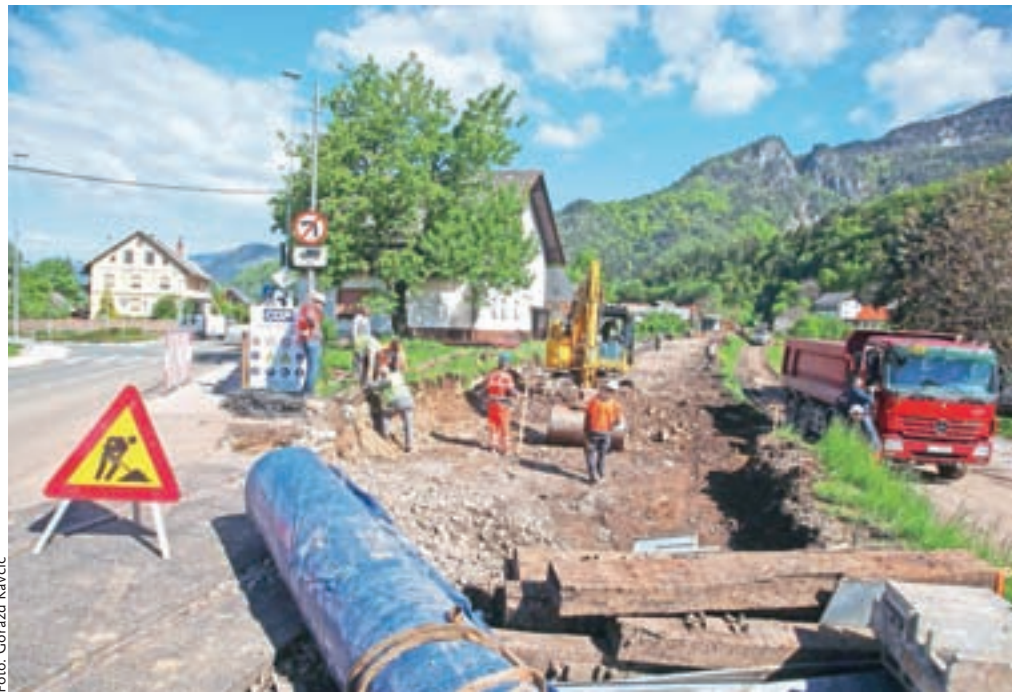
Veliko gradbišče je tudi v Žirovnici, kjer so tire že odstranili, dela pa intenzivno potekajo.
