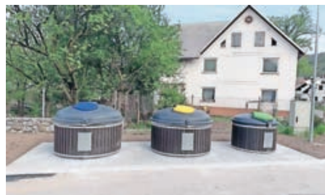
Prvi podzemni ekološki otok v Žirovnici
